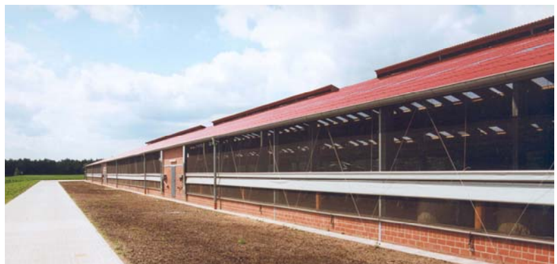
Abb. 5: Stallanlage mit Unterteilung in Brandbekämpfungsbereiche (BBB) durch „nicht brennbare Binderfelder“ (Foto: Huesker, abgeändert)
