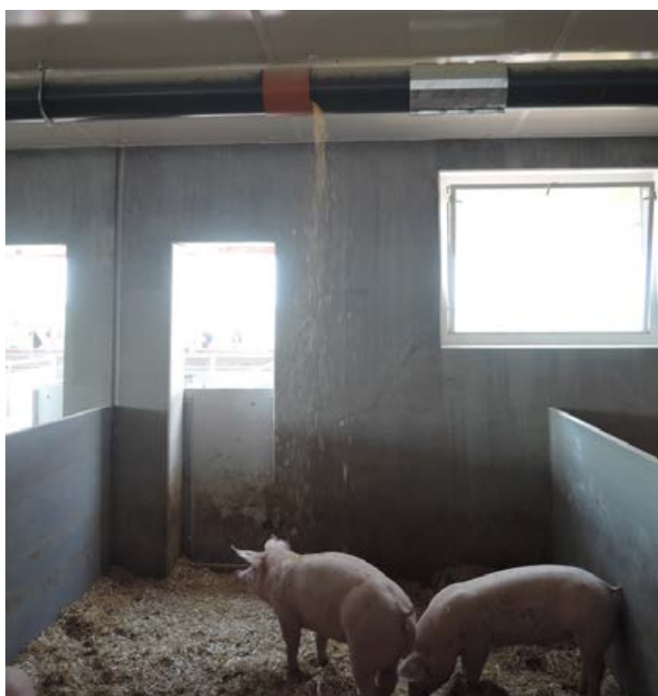
Abb. 14: Einbringen von Stroh mittels der „Strohmatic“ (Firma Schauer)
