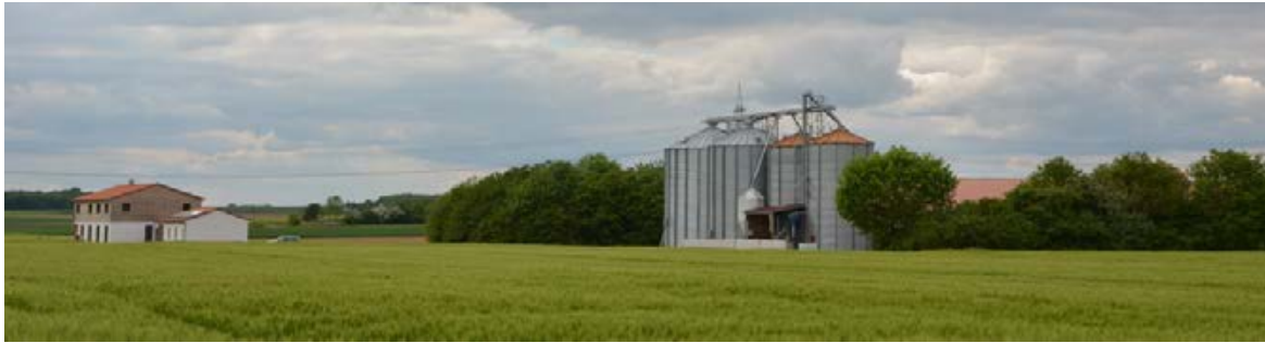
Abb. 1: Außenstandort mit Wohnhaus, Getreidelager, Ferkelaufzucht-, Schweinemast- und Tierwohlstall (Foto: Mack)
