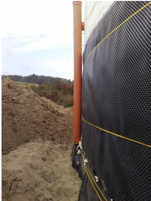
Erste Versuche mit Fundamentschutzbahn als Wandfolie
