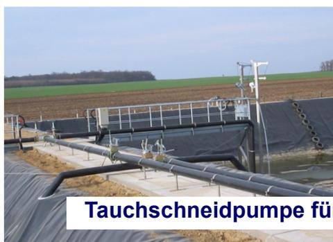
Tauchschnidpumpe für automatische Beckenleerung / Fassbefüllung
