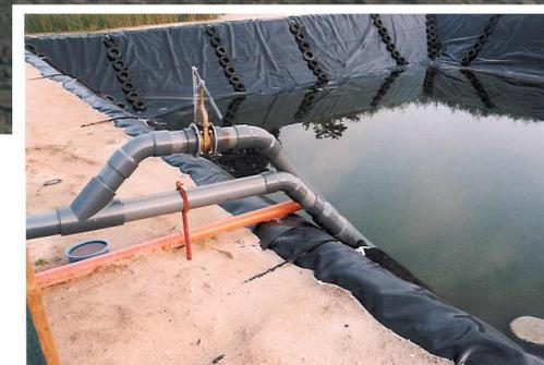
“Rühren” mit **geeignetem** Schlepperrührwerk .... Zu-/Ableitungen fest installiert
