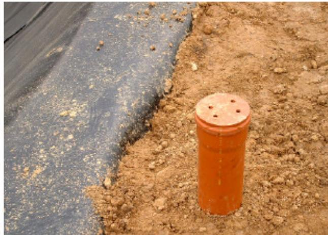
Das Entlüftungsrohr wird i.d.R. gegenüberliegend des Kontrollrohrs angeordnet und hat zum Ziel, eine Luftverdrängung zwischen den Auskleidungen -während der Erstbefüllung des Beckens- zu ermöglichen.
