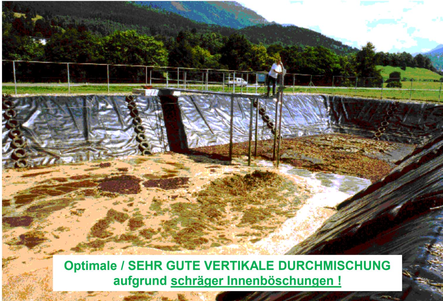
“Rühren” mit **Tauchrührtechnik** an Bedienbrücke >> effektive Durchmischung
