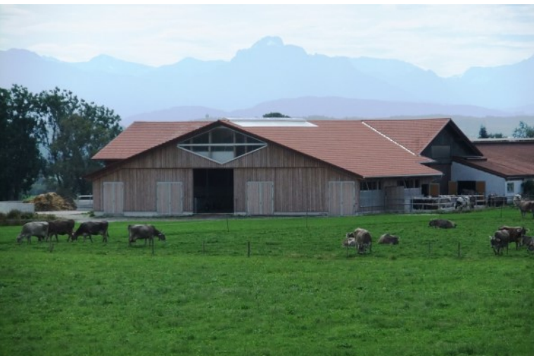
Bild 2: Ansicht von Nordosten
