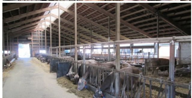
Bild 2 bis 4: Innenansicht - Neubau (oben), AMS Laktation 2+ (Mitte), Altstall (unten)
