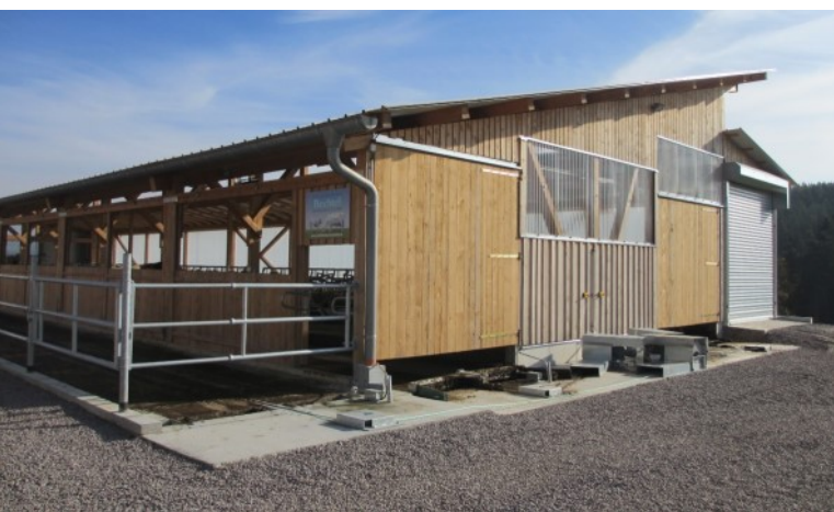
Bild 2: Ansicht von Westen
