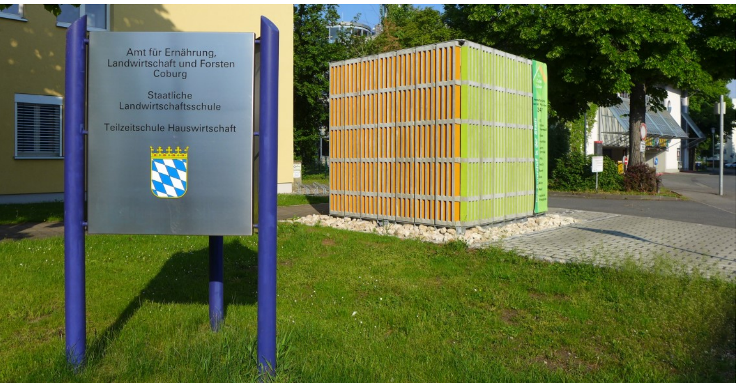
Bild 2: Blick von der Straße in die Zugangssituation zum AELF. Parkplatz zur Benutzung des Automaten im Vordergrund.
