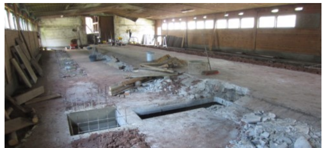
Bild 3: Alter Querkanal als Einwurfschacht / Doppelliegebox am ehemaligen Futtertisch
