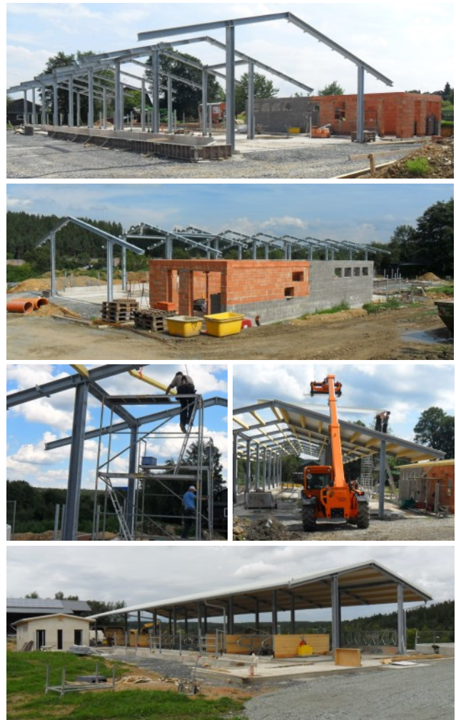
Bild 2 bis 6: Weiterer Bauverlauf
