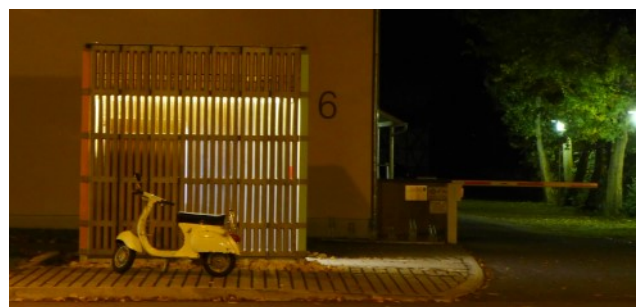
Bild 5: Nachts strahlt die LED Beleuchtung durch die Fassadenelemente
