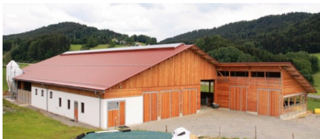
Bild 2: Gesamtansicht von Südosten
