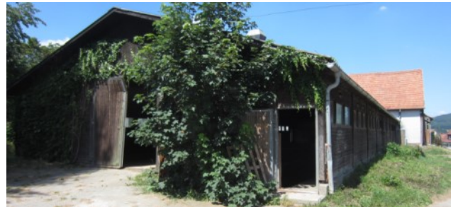
Bild 2: Außenansicht vor dem Umbau
