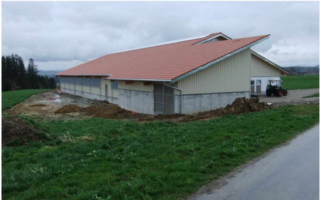
Bild 5: Ansicht von Nordwesten
