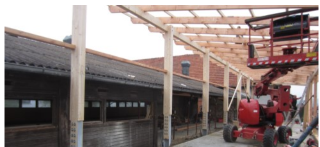
Bild 4: Ansicht vom Futtertisch - Stützen für Futtertisch und Altstall werden im Antritt integriert
