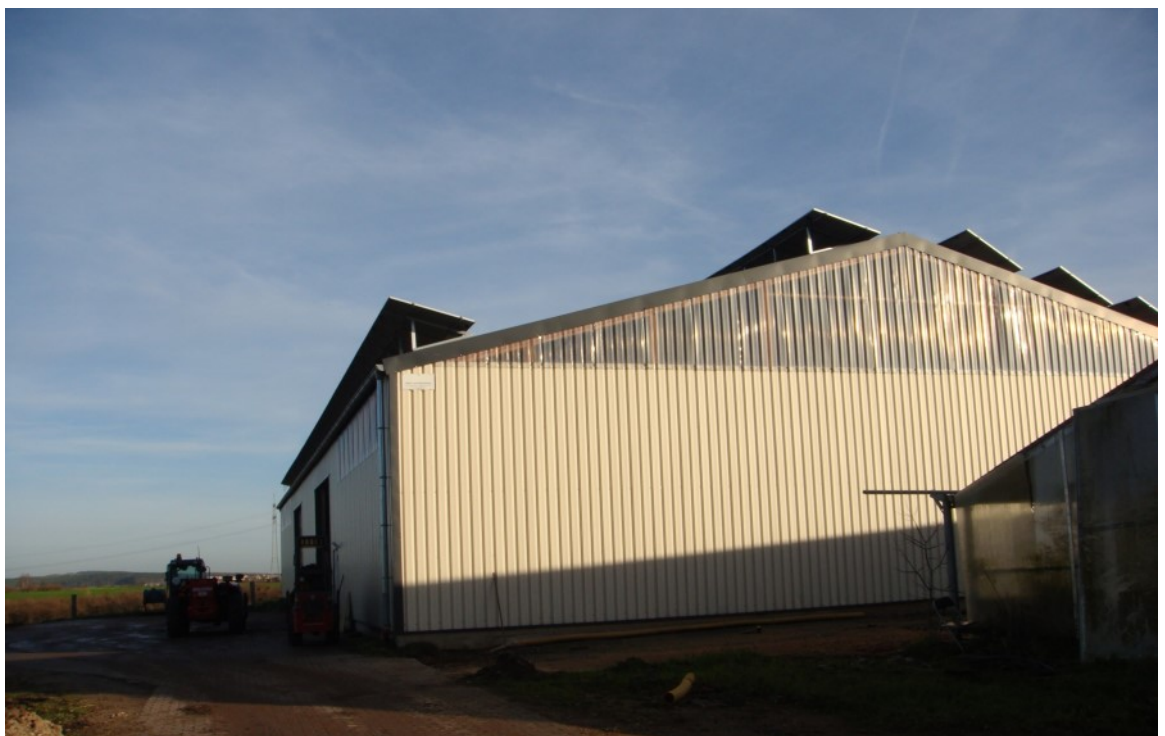
Bild 4: Teilaussiedlung der Grobverarbeitung (Waschen, Trocknen, Entkernen, Separieren)
