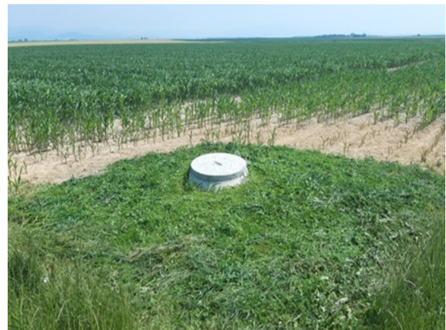
Bild 2: Optimal gestaltetes Brunnenumsfeld: Anböschung, mit Geländeneigung weg vom Brunnenkopf und Begrünung der Bodenoberfläche (Foto: A. Dorfmeister)
