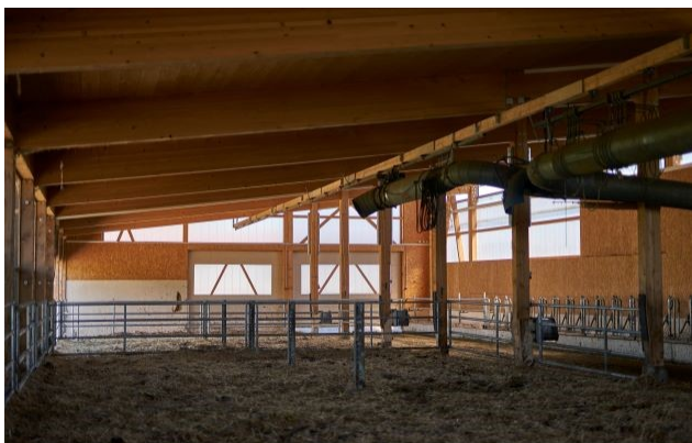
Bild 3: Liegefläche mit komb. Stroh- und Heufördersystem
