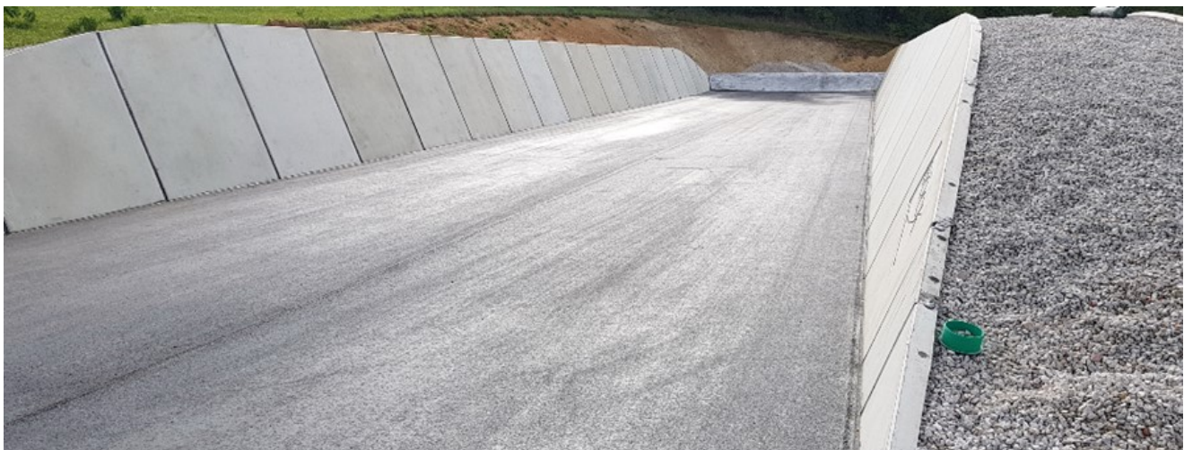
Bild 11: Asphalt - Betonfertigteil (Traunsteiner Wand); weitere Details siehe abZ/aBG, Anlage 1 - 6 (Quelle: Ronald Kriz, Böck Silosysteme GmbH)
