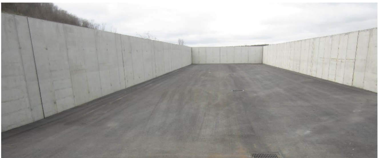
Bild 9: Asphalt - Ortbeton (gerade Wand) (Quelle: Klaus Hoffmann)
