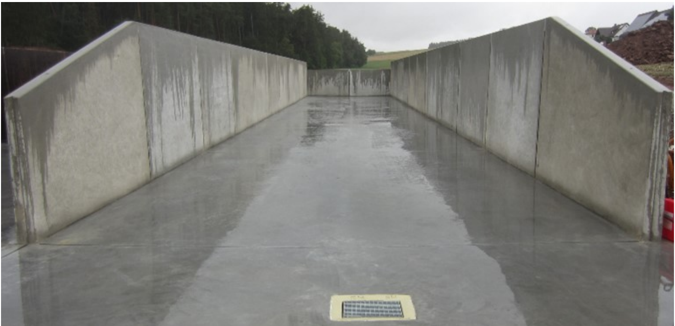
Bild 8: Ortbeton - Betonfertigteil (gerade Wand) (Quelle: Klaus Hoffmann)
