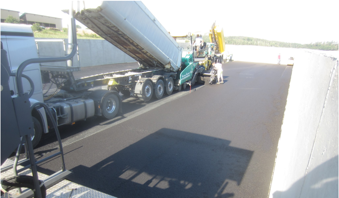
Bild 4: Einbau „heiß an heiß“ mit zwei Asphaltfertigern (Quelle: K. Hoffmann)
