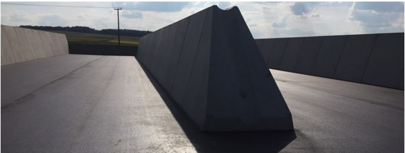
Bild 10: Asphalt - Betonfertigteil (schräge Wand)
