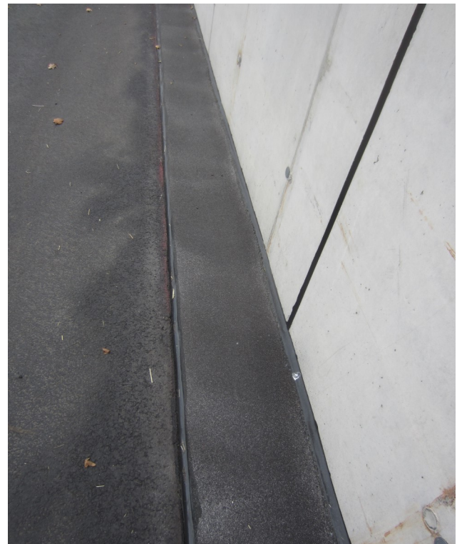
Bild 3: Gußasphaltstreifen entlang der aufgehenden Wand (Quelle: K. Hoffmann)
