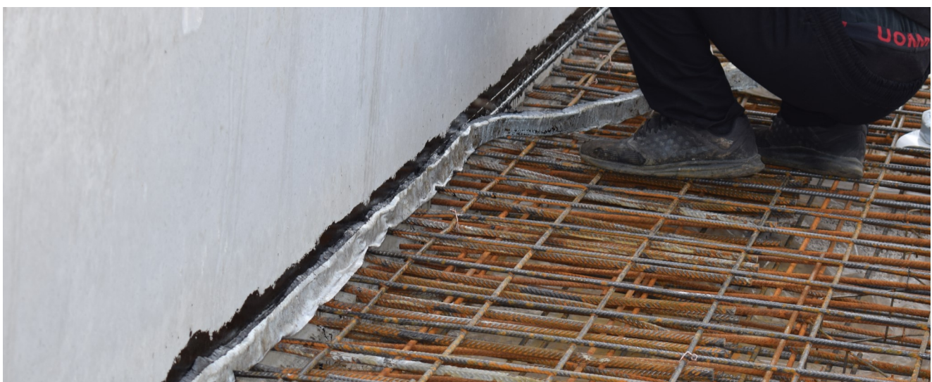
Bild 5: Anbringen des bituminösen Fugenbandes an das Fertigteil (Quelle: Firma Uhrle)
