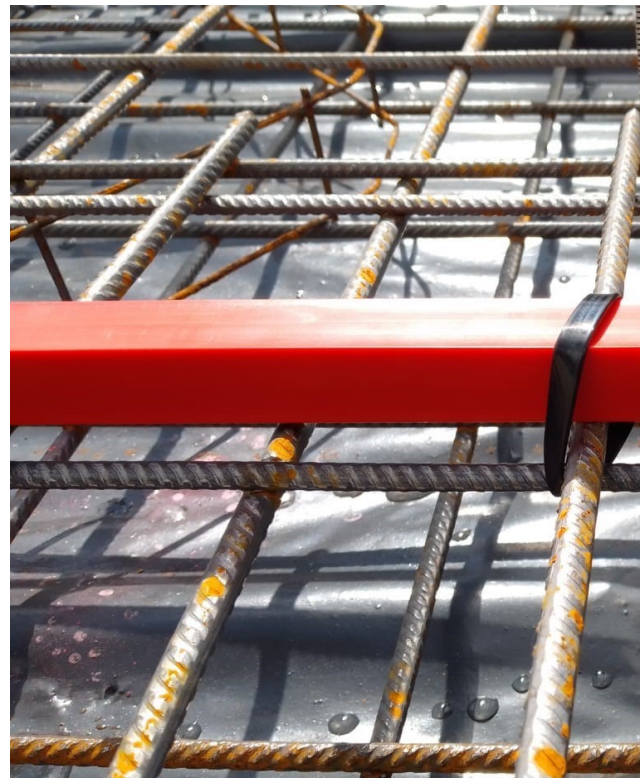
Bild 1: Eingebautes Kunststoffvollprofil (Quelle: Firma Hacker)
