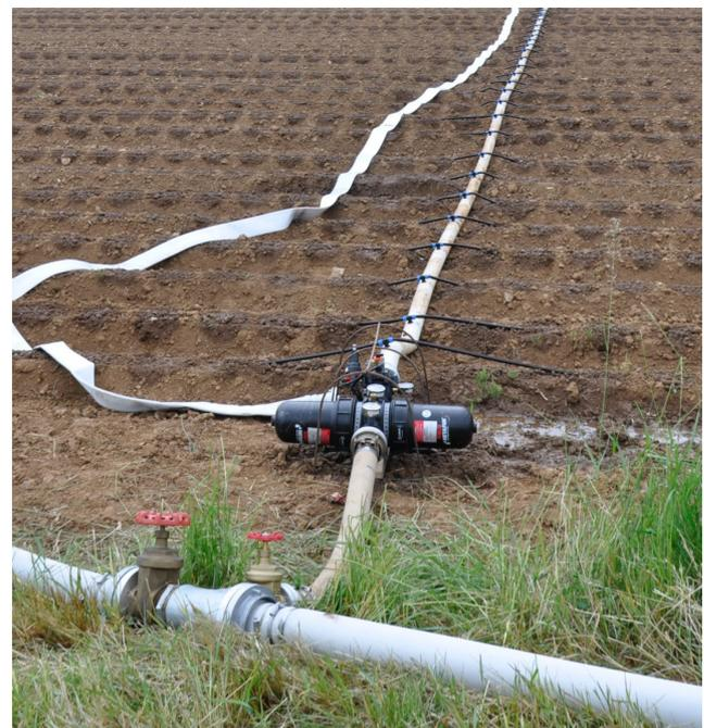
Bild 1: Komponenten einer Tropfbewässerungsanlage für Möhren - Zuleitung, Doppelscheibenfilter, Querleitung (Netafim FlexNet) und Tropfsystem, Quelle: S. Schwab
