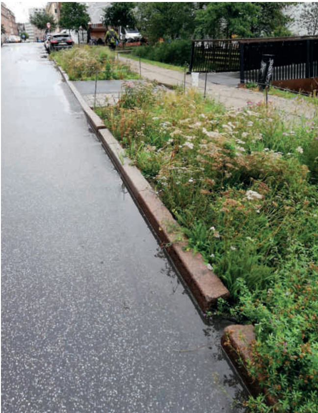
Bild 1 a,b: Oberflächenwasser von gering belasteten Straßen wird in Kopenhagen direkt in Pflanzflächen eingeleitete Einläufe werden im Herbst auf Winterbetrieb umgestellt und leiten das salzbelastete Wasser in den Abwasserkanal (N. Kendzia)
