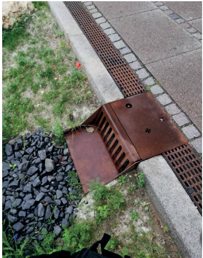
Bild 1 a,b: Oberflächenwasser von gering belasteten Straßen wird in Kopenhagen direkt in Pflanzflächen eingeleitete Einläufe werden im Herbst auf Winterbetrieb umgestellt und leiten das salzbelastete Wasser in den Abwasserkanal (N. Kendzia)
