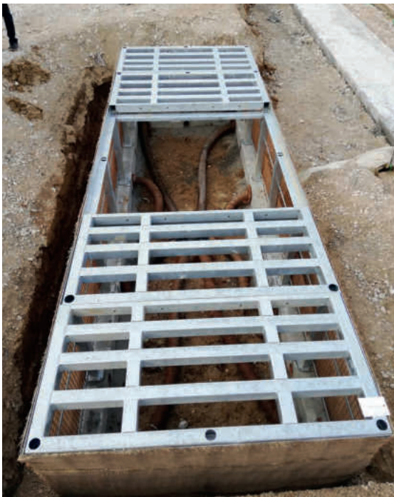
Bild 2 a,b: Ein stabiles Kastensystem wurde auf der Landesgartenschau Ingolstadt 2020 eingebaut. Hier sind Rohre zur Belüftung und Wasserverteilung bereits vorgesehen. Eine Überbauung mit Belagsflächen wird somit ermöglicht (N. Kendzia)
