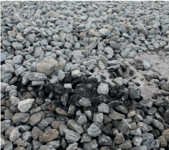
Bild 6 a,b: In das Struktursubstrat werden Bodenhilfsstoffe wie Pflanzenkohle eingeschlämmt (links); die Baumpflanzung wurde um eine artenreiche Unterpflanzung ergänzt (rechts) (R. Höger, Gartenamt, Stadt Würzburg).
