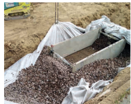
Bild 7 (links): Vom Deutschen Institut für Bautechnik (BIBt) zugelassene Sickerrinne (N. Kendzia)
