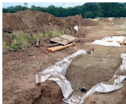
Bild 7 (links): Vom Deutschen Institut für Bautechnik (BIBt) zugelassene Sickerrinne (N. Kendzia)
