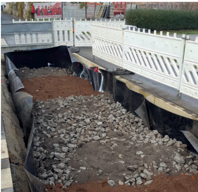
Bild 5 a,b: Struktursubstrat aus Schotter für einen stabilen und versickerungsfähigen Grundaufbau für den Baumstreifen; die Bäume selbst wurden in das Baums substrat gepflanzt, für die Staudenpflanzung wurde Oberboden angedeckt (R. Höger, Gartenamt, Stadt Würzburg)
