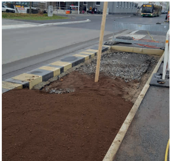
Bild 5 a,b: Struktursubstrat aus Schotter für einen stabilen und versickerungsfähigen Grundaufbau für den Baumstreifen; die Bäume selbst wurden in das Baums substrat gepflanzt, für die Staudenpflanzung wurde Oberboden angedeckt (R. Höger, Gartenamt, Stadt Würzburg)
