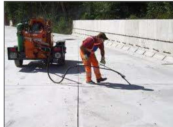
Der Beton muss i. d. R. innerhalb von ca. 24 Stunden gekerbt werden. **Fugen** können gemäss den ZTV Fug-StB geschnitten werden, **wenn 70% der Endfestigkeit erreicht sind.**
