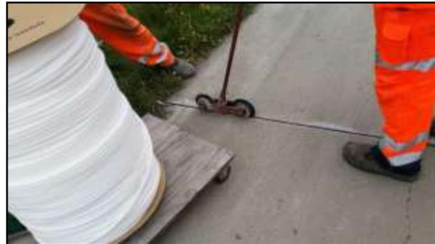
Mit dem Unterfüllstoff wird die Fuge dimensioniert und wird die Drei-Seiten-Haftung ausgeschlossen.
