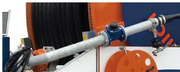
**Bild 4:** Wasserzähler im Zulauf zu Beregnungsmaschine (Foto: Fa. Beinlich)
