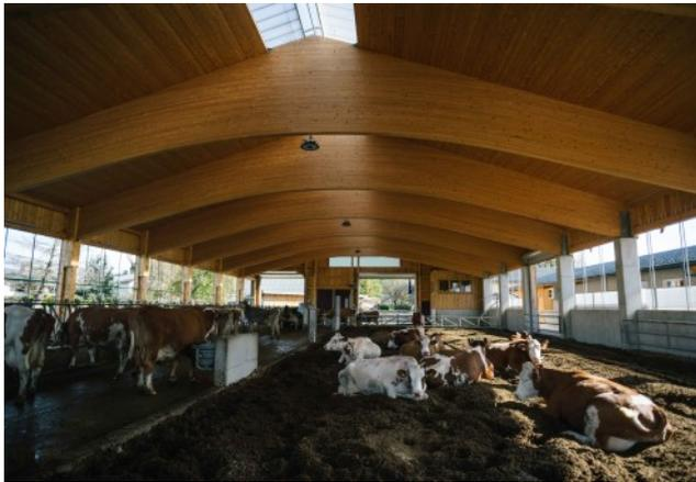
**Bild 23:** Die freitragende Halle bietet eine 500 m<sup>2</sup> große Kompostfläche.
