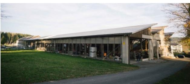
**Bild 14:** Das dreiteilige Sheddach mit Firstöffnungen von 1,50 m und 4 m sorgt für eine sehr gute Luftzirkulation.
