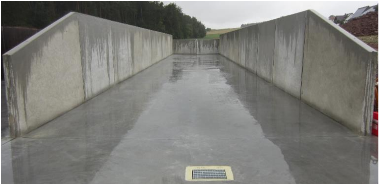
Bild 8: Ortbeton - Betonfertigteil (gerade Wand) (Quelle: Klaus Hoffmann)
