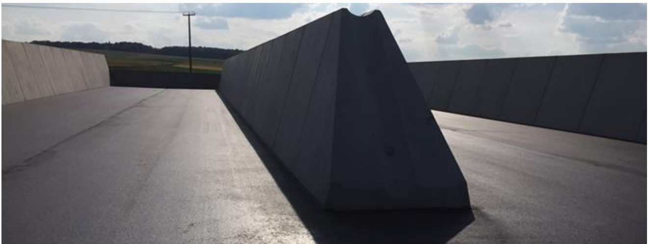
Bild 10: Asphalt - Betonfertigteil (schräge Wand)
