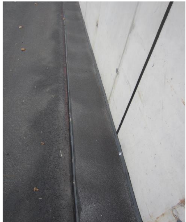
Bild 3: Gußasphaltstreifen entlang der aufgehenden Wand (Quelle: K. Hoffmann)
