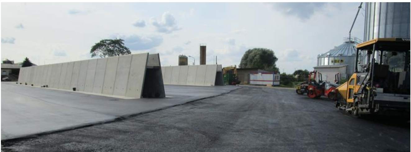
Bild 12: Asphalt - Betonfertigteil begehbar (schräge Wand) (Quelle: Manuel Geyer, Agrargenossenschaft Neumark)
