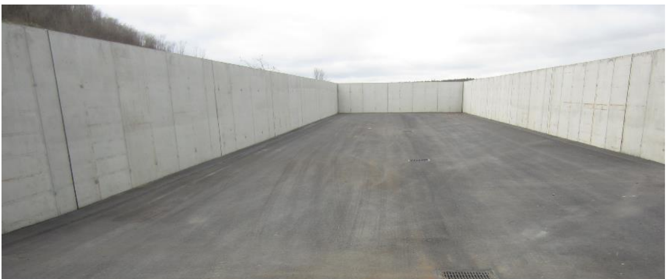
Bild 9: Asphalt - Ortbeton (gerade Wand) (Quelle: Klaus Hoffmann)
