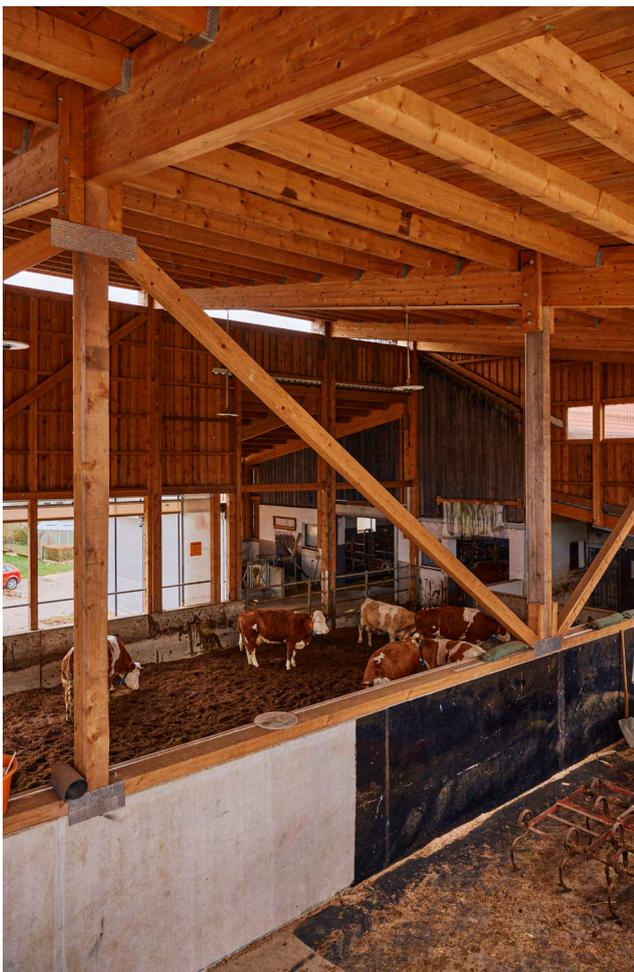
**Bild 31 a-b:** Innenansicht Kompost-Liegehalle mit Übergang in den Fressbereich sowie den Vorwarteraum (a), daran anschließend der Lagerbereich für Kompostsubstrat (b)
