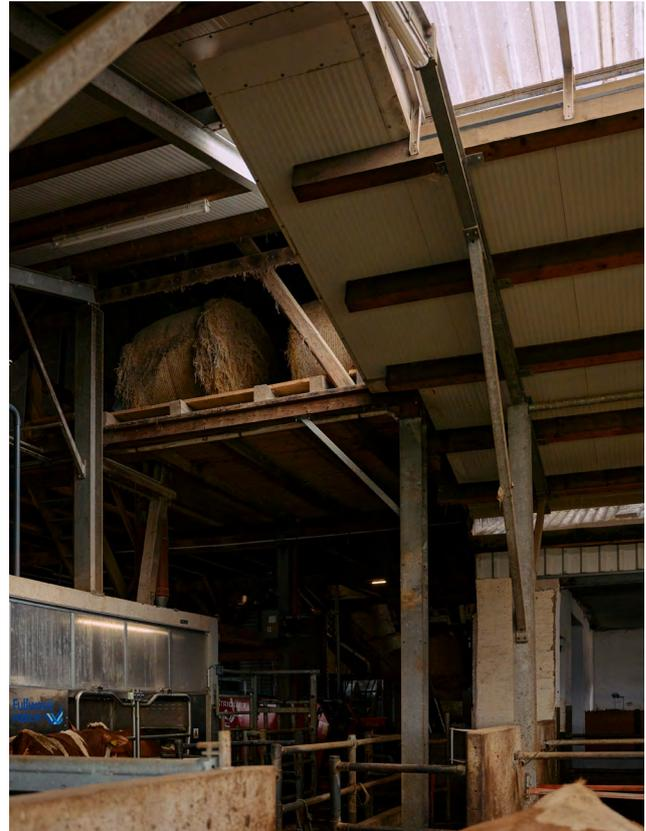
**Bild 52:** Übergang zwischen Altgebäude, angebauter Liegehalle und bestehender Scheune
