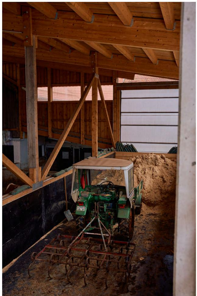
einer Pfosten-Riegel-Konstruktion mit Boden-Deckelschalung. Das Melkhaus wurde in Massiv-
