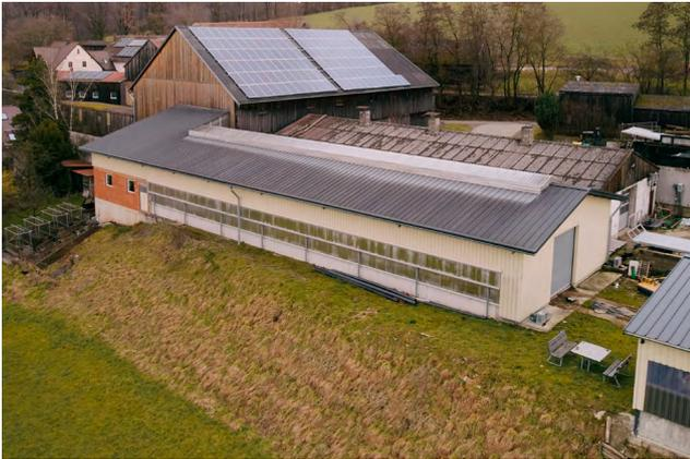
**Bild 46:** Zum Anbau der Liegehalle war die Aufschüttung mit Erdreich zum Ausgleich der Hanglage notwendig
