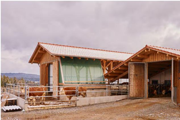
**Bild 17:** Verlängerung des Altstalles und Laufhof vor der neuen Liegehalle, im Vordergrund rechts Blick auf Abkalbe- und Trockensteherbereich
