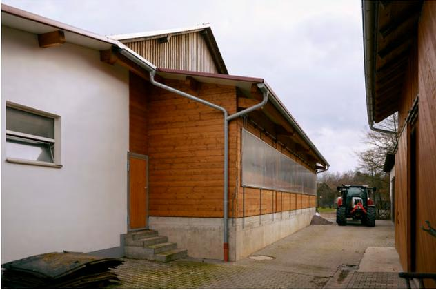
**Bild 6:** Anbau Liegehalle mit Vollholzwänden und Hubfenster
