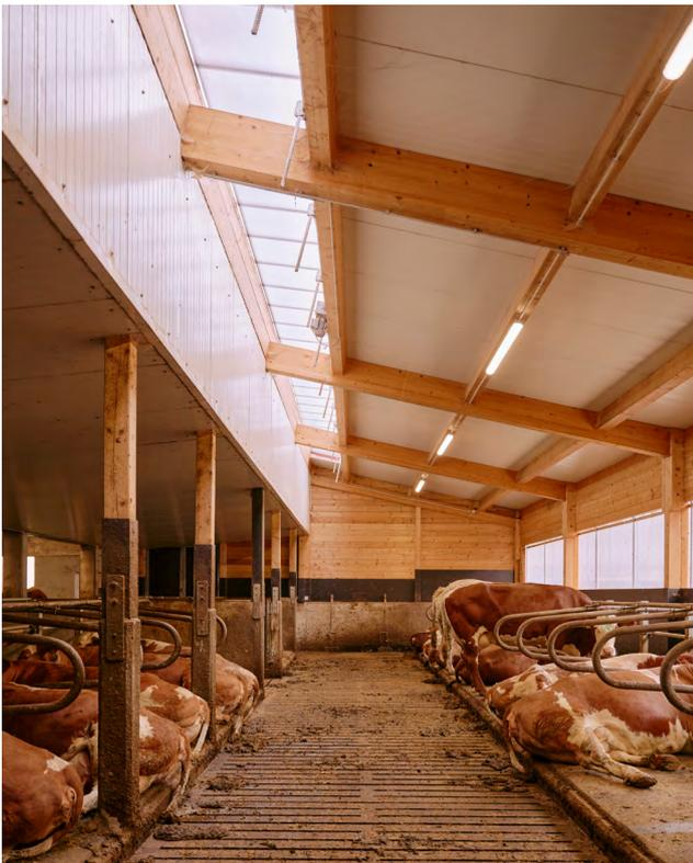
**Bild 7:** Innenansicht Liegehalle mit Licht-Luft-First
